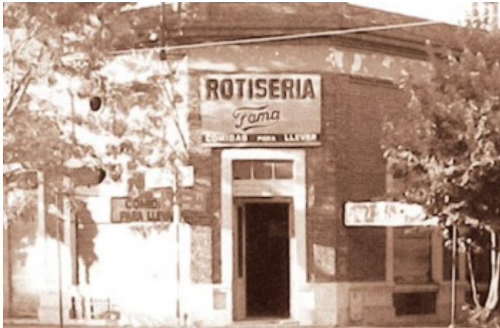
Fachada del edificio cuando funcionaba allí la Rotería Fama
